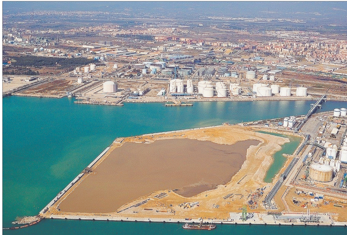
Ya se ha terminado el cierre perimetral del futuro muelle de la Química. FOTO: PORT DE TARRAGONA
